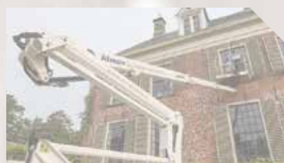
SCHILDERWERK (BINNEN EN BUITEN)
