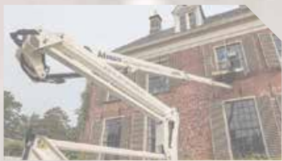
SCHILDERWERK (BINNEN EN BUITEN)
