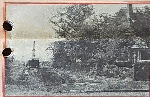
Foto 9: Een simpele foto, maar zo historisch! De doorbraak wordt gemaakt van de Westersedrift naar de toekomstige snelweg. Het zou dus het verlengde worden van de Emmalaan in westelijke richting. Voor deze doorbraak werden door de gemeente twee tuinen aangekocht.
