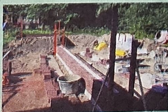
De mannen van Bartelds gaan aan de slag, beginnen bij het begin...
