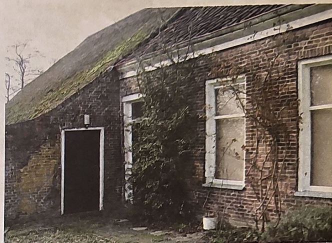
Onder dit raam stond een waterbak, aangesloten op de dakgoot, voor het drinkwater.
