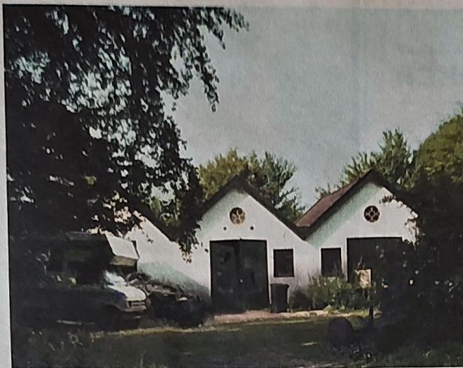
De bouwval met de markante puntdakjes...
