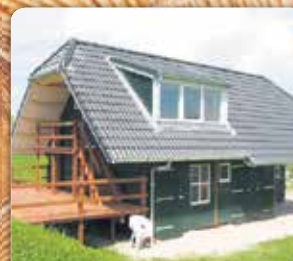
Huis met veranda 6.00 x 10.00 m. compl. geïsoleerd. Sneldakpannen, garage/berging met hobbyruimte. (Richtprijs compleet geplaatst) € 55.000,-
