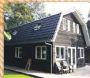
Zomerhuis aan het Paterswoldsemeer uitgevoerd in gepotdekseld hout met gebakken pannen.
