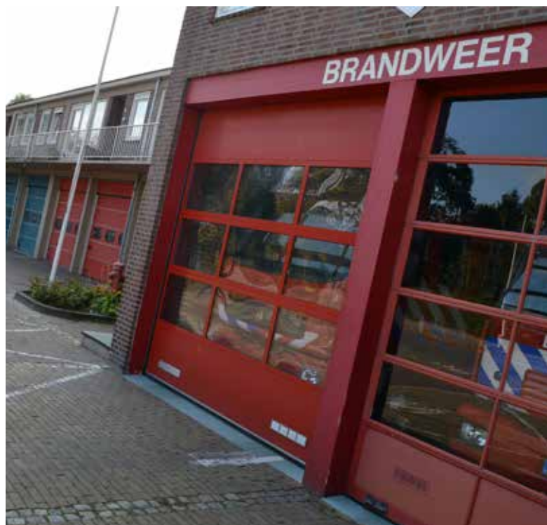
De huidige brandweerkazerne, die niet voldoet aan de arbo-eisen.
