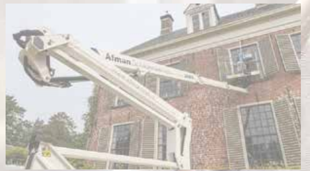
SCHILDERWERK (BINNEN EN BUITEN)
