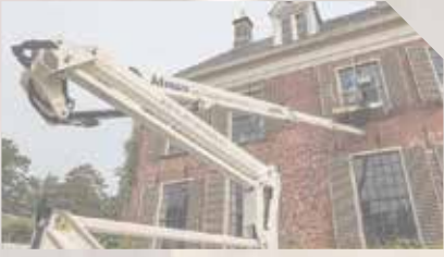
SCHILDERWERK (BINNEN EN BUITEN)
