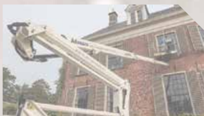
SCHILDERWERK (BINNEN EN BUITEN)
