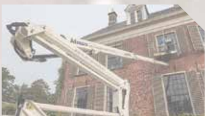
SCHILDERWERK (BINNEN EN BUITEN)
