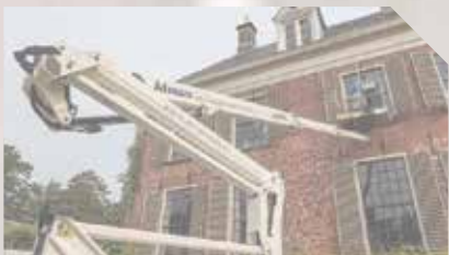
SCHILDERWERK (BINNEN EN BUITEN)
