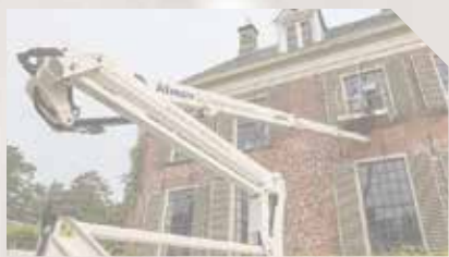
SCHILDERWERK (BINNEN EN BUITEN)
