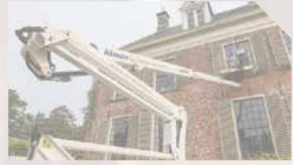
SCHILDERWERK (BINNEN EN BUITEN)
