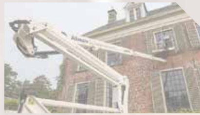
SCHILDERWERK (BINNEN EN BUITEN)
